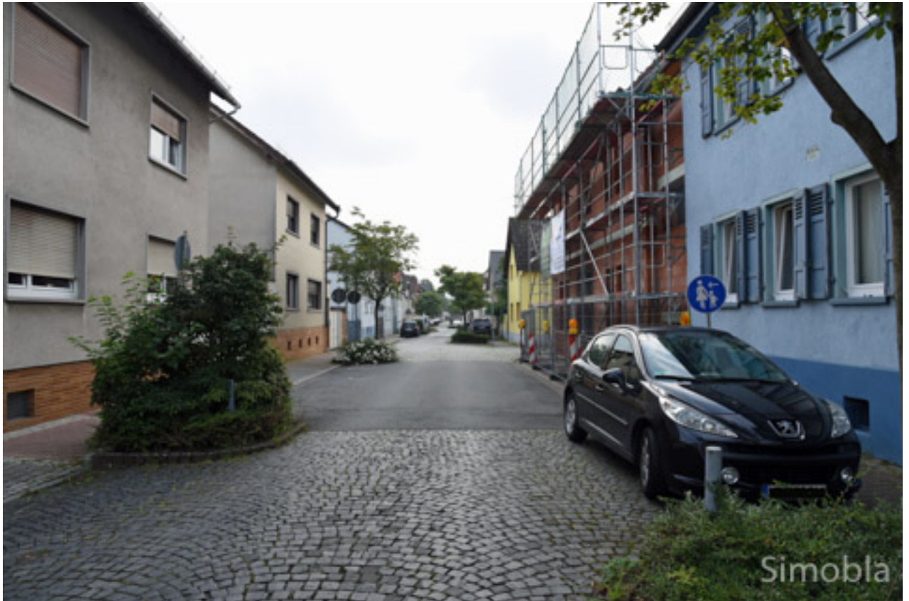
Kopfsteinpflaster nur auf den Schwellen, verputzte Fassaden, Bäume und Autos: die Allesinastraße jetzt. Foto: Michael Sittig
